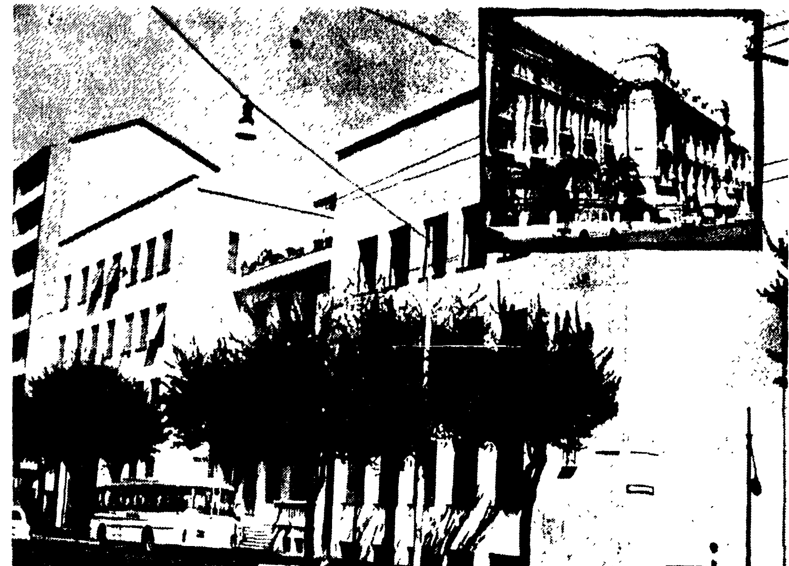
Ecco due volti della stessa realtà: due foto scattate in Trastevere, a pochi passi dal ministero della Pubblica Istruzione, ci danno un'immagine perfetta delle condizioni della scuola italiana.
