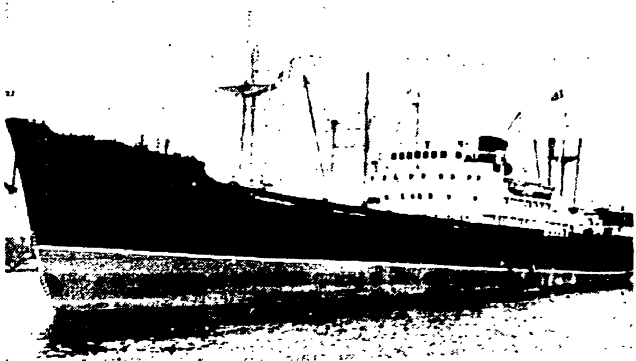
MADAGASCAR — Una immagine della nave «Star Carrier» esplosa nel porto di Diego (Telefoto)
