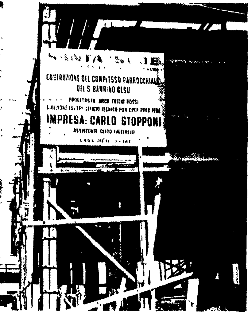
Il cantiere inalterato sul cantiere della costruenda chiesa del Bambin Gesù in via Campi Flegrei
