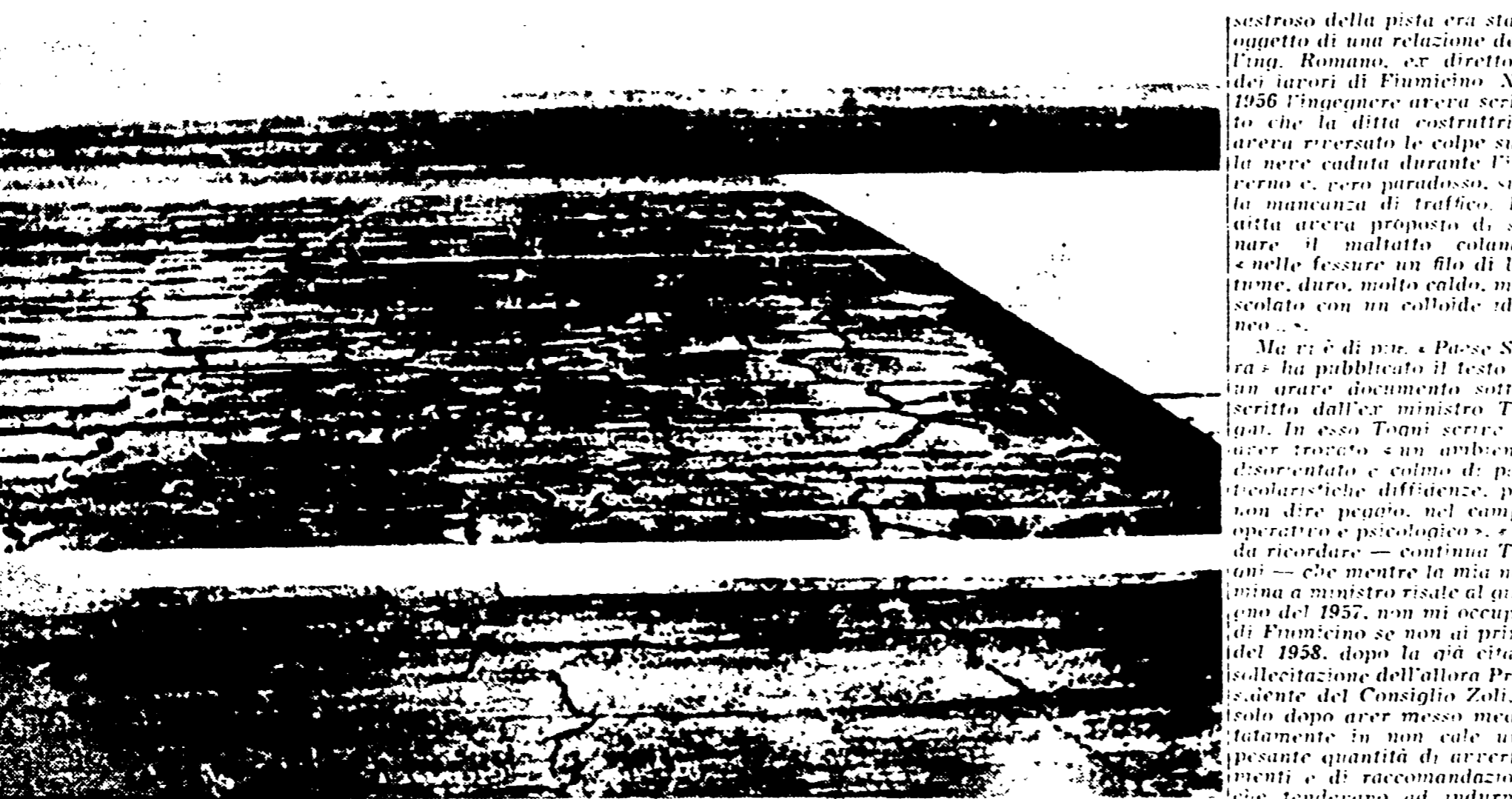
Ecco come era ridotta la pavimentazione della pista principale dell'aeroporto di Fiumicino il 25 settembre 1958, dopo che erano già stati spesi ben 14 miliardi di lire. La foto venne scattata con una speciale pellicola sensibile agli infrarossi che permette la rilevazione delle crepe. Sulla destra della foto si scorge un triangolo più chiaro; in questa parte della pista era stata tentata una copertura delle frane con una gettata di macadam
