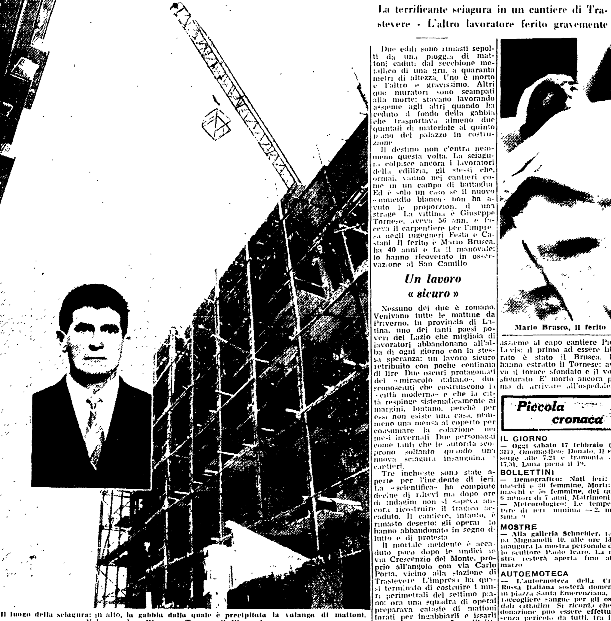
Il luogo della sciagura: in alto, la gabbia dalla quale è precipitata la valanga di mattoni. Nel riquadro: Giuseppe Tornese, l'edile ucciso.
