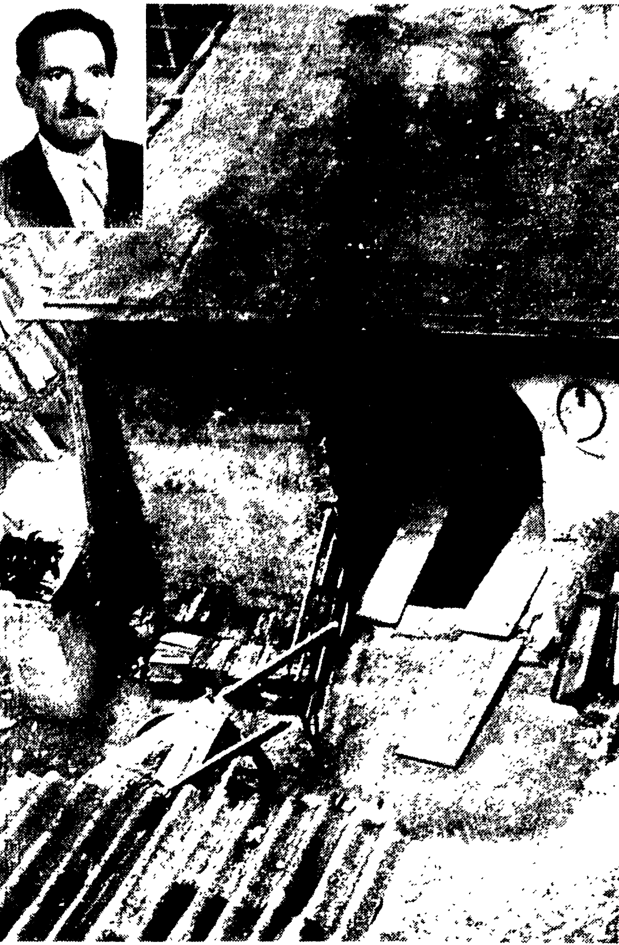
Il pozzo della calce, nel quale Antonio Deida (nel riquadrato) è precipitato: sono ben visibili le maltesure tavole sulle quali l'operaio stava lavorando
