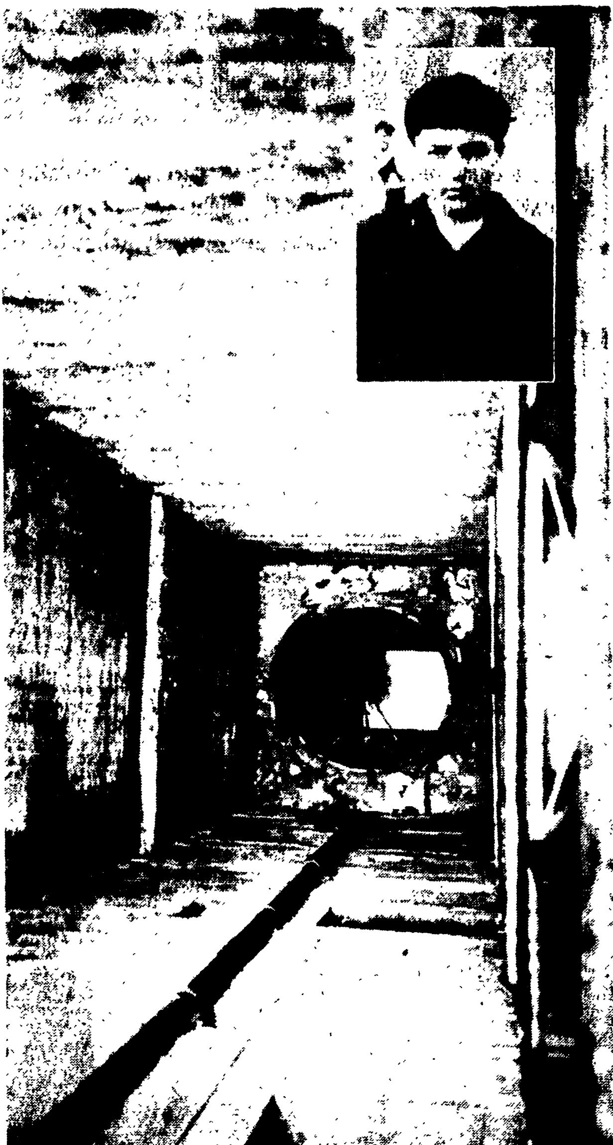
La tromba delle scale e in fondo il lucernario sul quale è piombato il ragazzo dopo il drammatico volo di oltre 20 metri. Nella foto piccola: Lino Stoppioni
