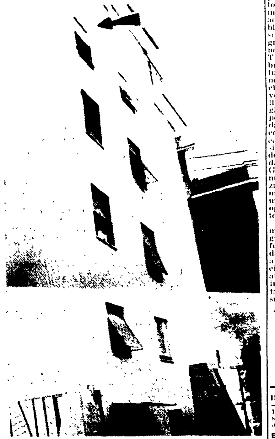
La palazzina in via delle Sette Chiese 52. La freccia indica la finestra dalla quale è precipitato l'edile
