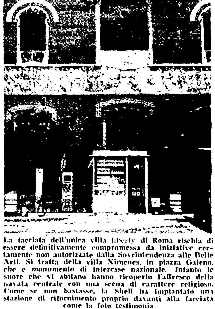
La facciata dell'unica villa liberty di Roma rischia di essere definitivamente compromessa da iniziative certamente non autorizzate dalla Sovrintendenza alle Belle Arti. Si tratta della villa Ximenes, in piazza Galeno, e che è monumento di interesse nazionale. Intanto le suore che vi abitano hanno ricoperto l'ingresso della navata centrale con una sorta di carattere religioso. Come se non bastasse, la Shell ha impiantato una stazione di rifornimento proprio davanti alla facciata come la foto testimonia.
