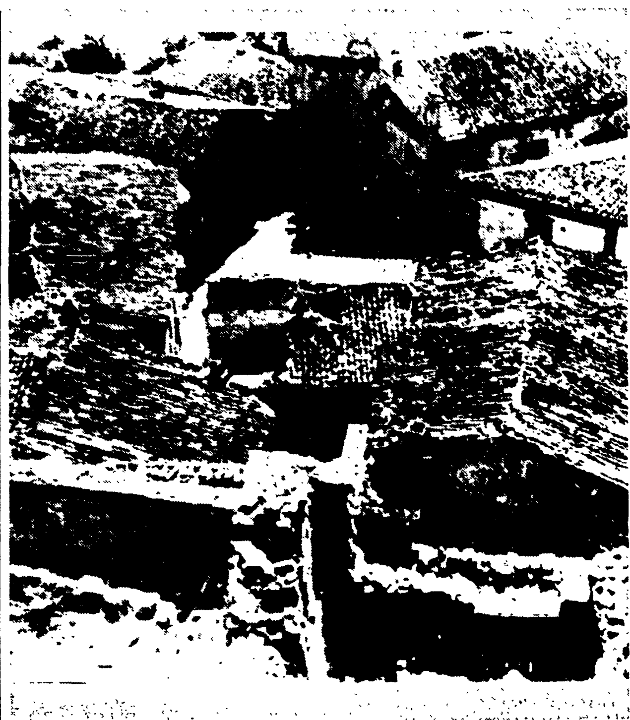
MOLINARA - Una squallida veduta del panorama di case lesionate o già fatte crollare dal terremoto (Telefoto)
