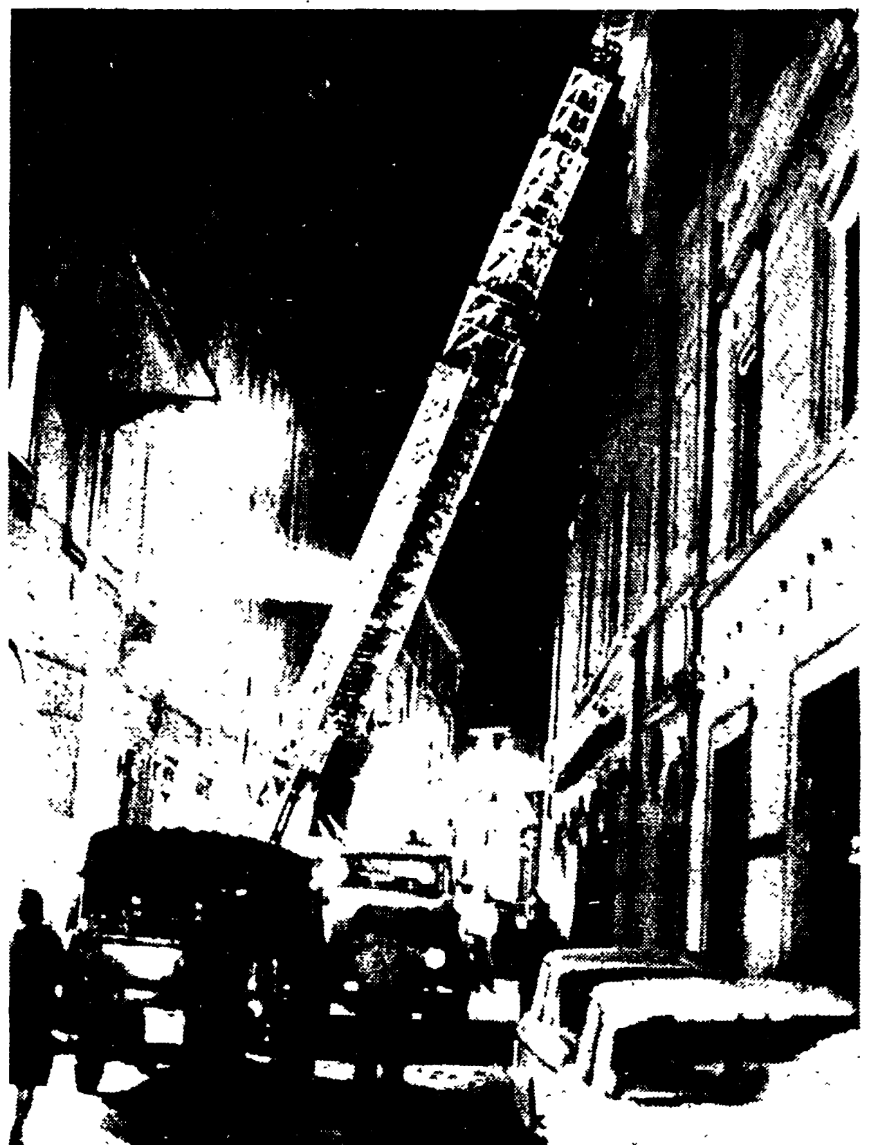
Due colombi, seava scava per farsi un nido, hanno messo in pericolo una parte del cornicione di intonaco che ha sfiorato una passante. I vigili del fuoco, con una autocarica, hanno rimosso ferri sera i calcinacci pericolanti non tralasciando di spostare nido e colombi sopra un cornicione più resistente
