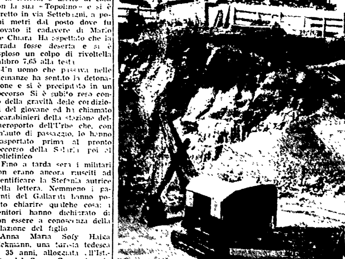
Cinque casette di via S. Colombano all'EUR rischiano di crollare da un momento all'altro, perché una ruspa dell'impresa Santaroni ha lesionato le loro fondamenta. Per la costruzione di un nuovo palazzo, l'impresa ha scavato una voragine di 20 metri proprio a ridosso delle casette, per le quali gli inquilini pagano l'affitto al Comune. Sul muro delle case si sono già aperte minacciose crepe: le cinghiale famiglie che vi abitano saranno costrette ad abbandonarle, se gli scavi non verranno sospesi. (Nella foto: la ruspa sotto le casette pericolanti).
