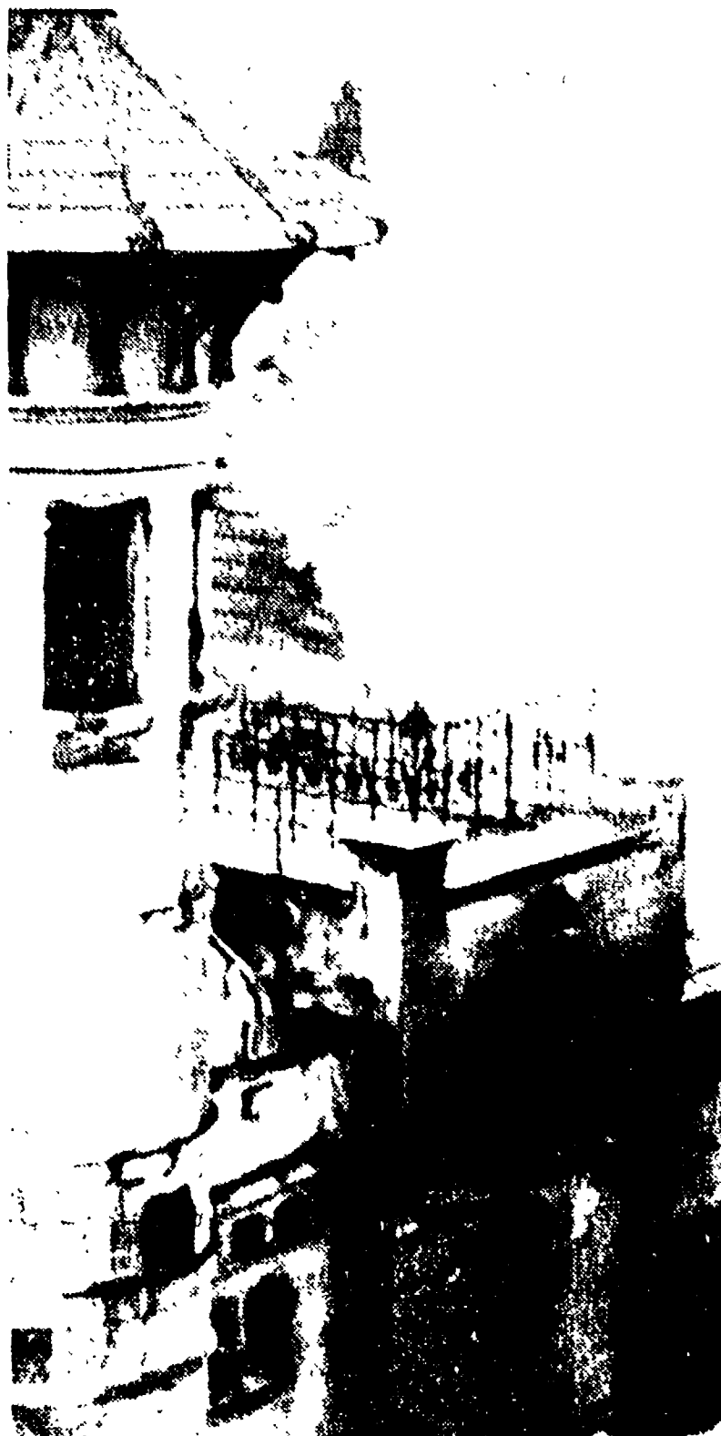
Villa Florio, a Palermo, è stata quasi interamente distrutta da un incendio forse doloso. Da tempo l'area sulla quale sorge l'immobile aveva richiamato l'attenzione degli speculatori che intendevano acquistarla.
