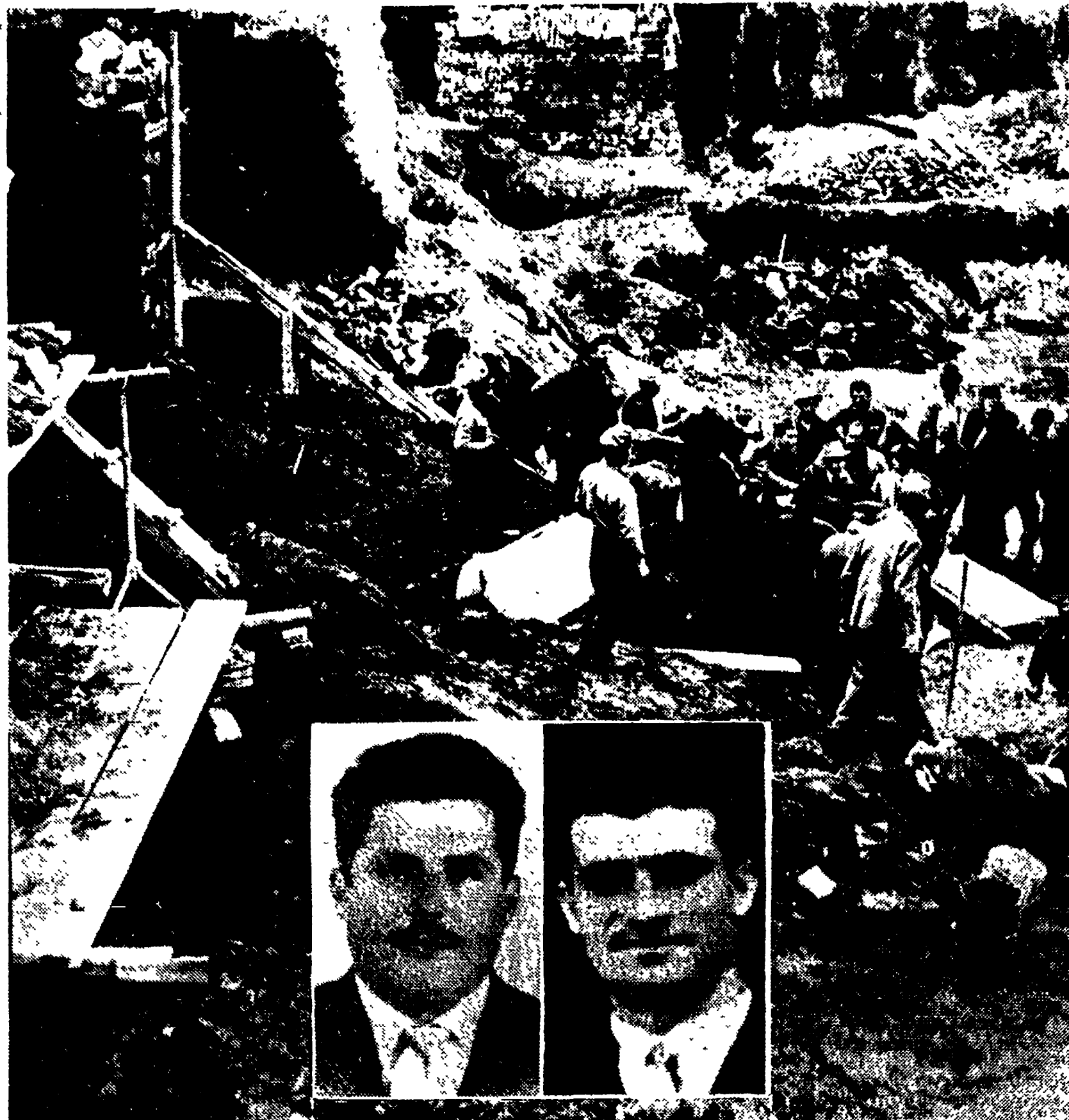
Il cantiere di via Baccarini dove è avvenuta la sciagura. Nelle foto piccole le vittime: Antonio Orsini (a sinistra) e Enrico Chicarella
