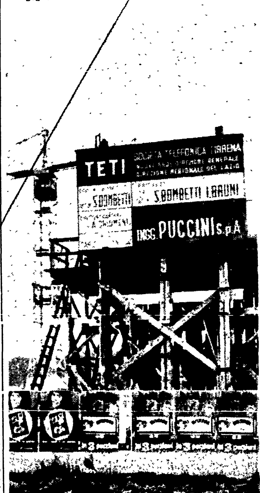
La nuova sede della TETI in costruzione.
