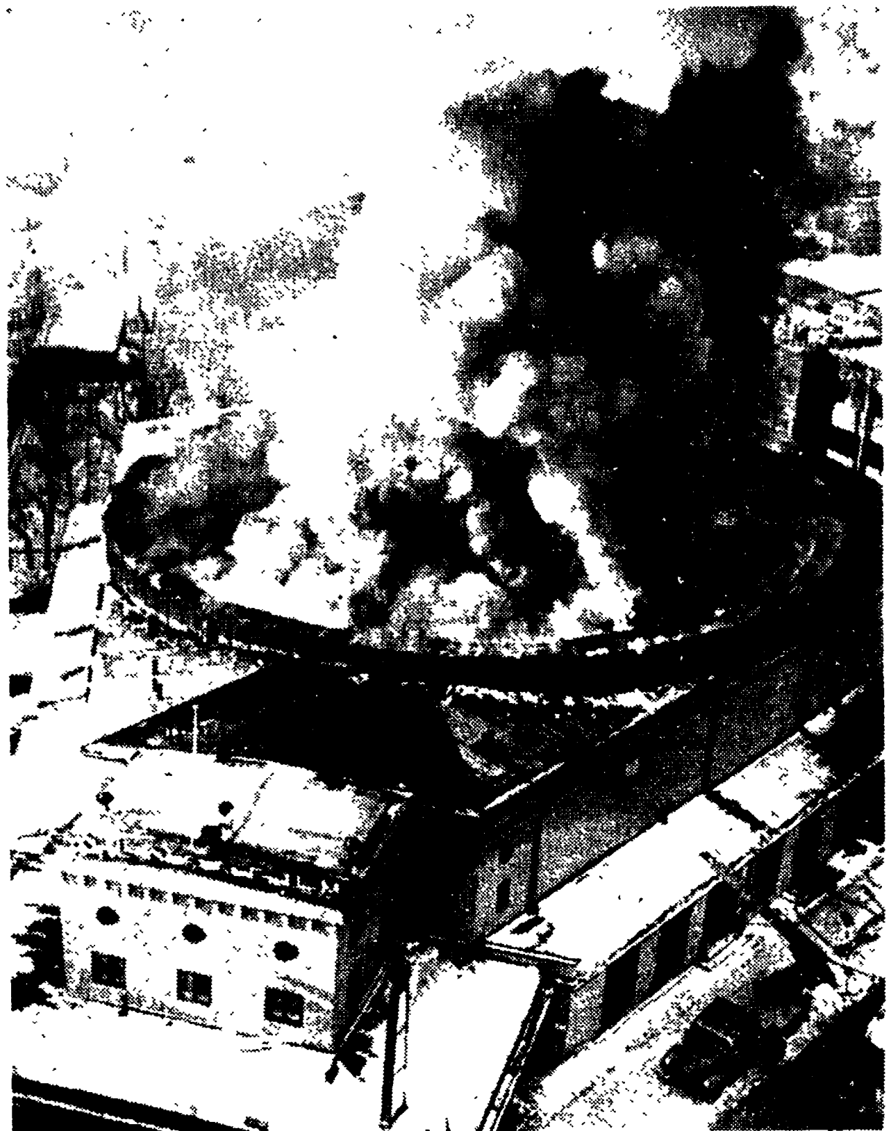
OSLO (Norvegia) — Una drammatica foto, scattata da un aereo a bassa quota, del violento incendio che ha colpito il cinematografo più moderno di Oslo, il «Colosseo» che è stato praticamente raso al suolo con un danno valutato ad oltre mezzo miliardo di lire. Il cinema ha una pianta circolare e dal suo tetto si vede levarsi dense nubi di fumo biancastro. In primo piano in basso è visibile una delle automappe dei vigili del fuoco accorsi per domare le fiamme.
