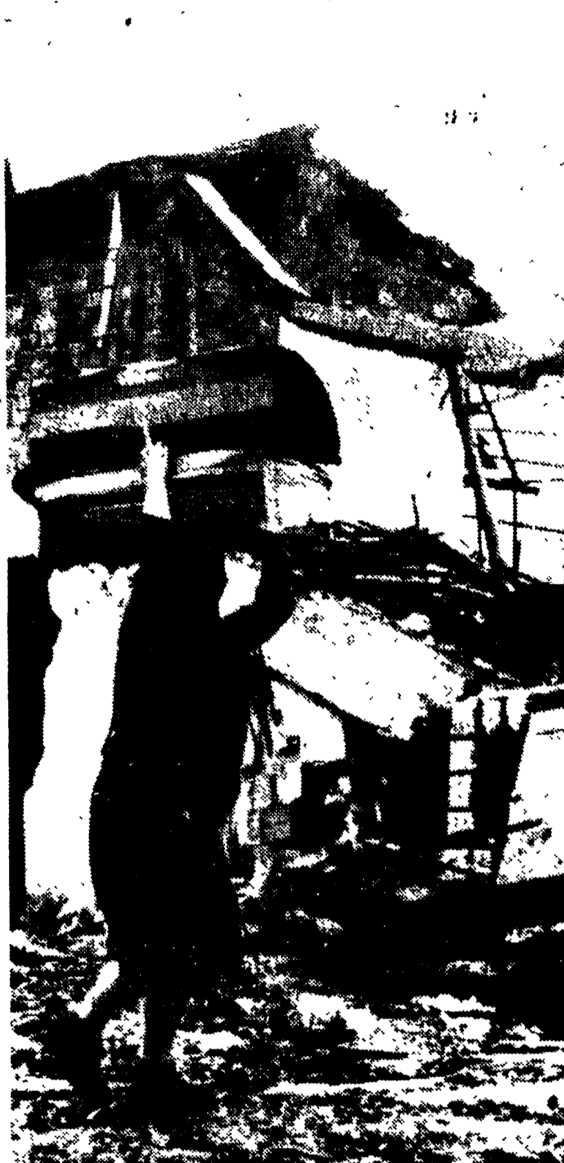
CAPOSELE — Si abbandonano le case pericolanti cercando di trasportare fuori le masserizie (Telefoto)
