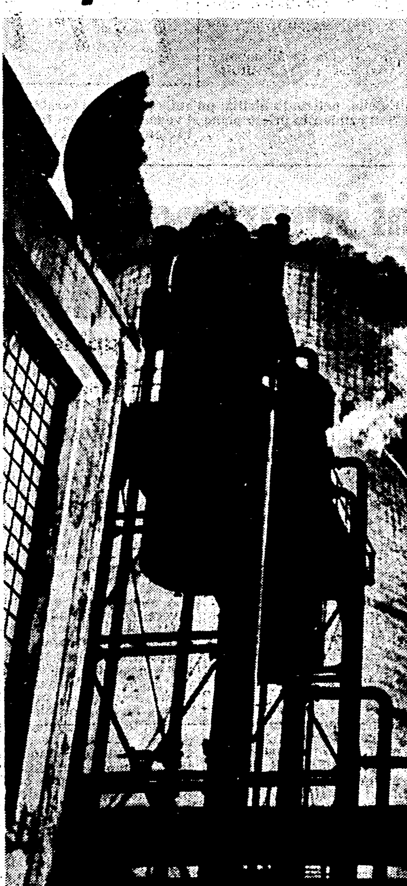
Un particolare degli impianti a Larderello
