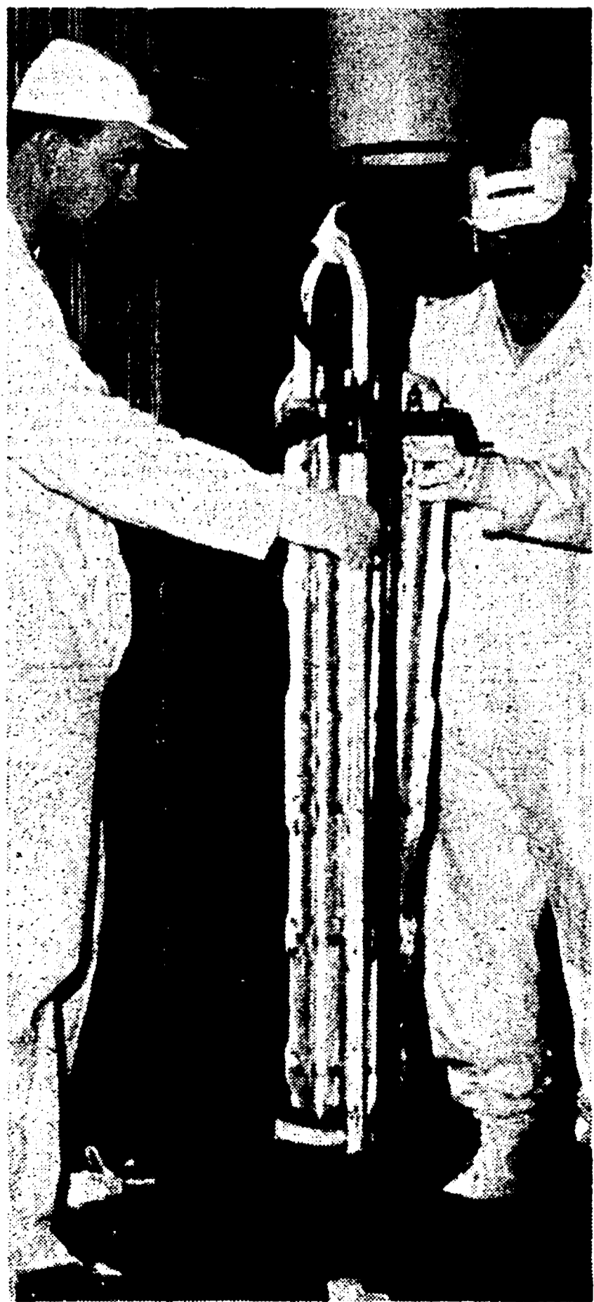
LATINA — L'interno del reattore della centrale nucleare SIMEA durante il caricamento dell'ultimo elemento di combustibile prima dell'entrata del reattore nella fase critica.
