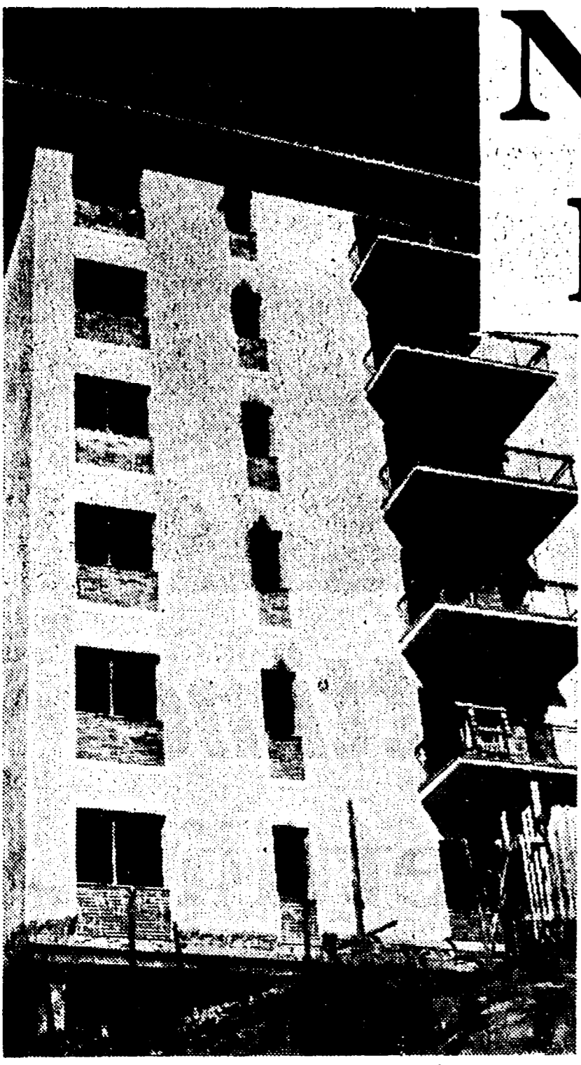
Casa in costruzione dell'IACP
