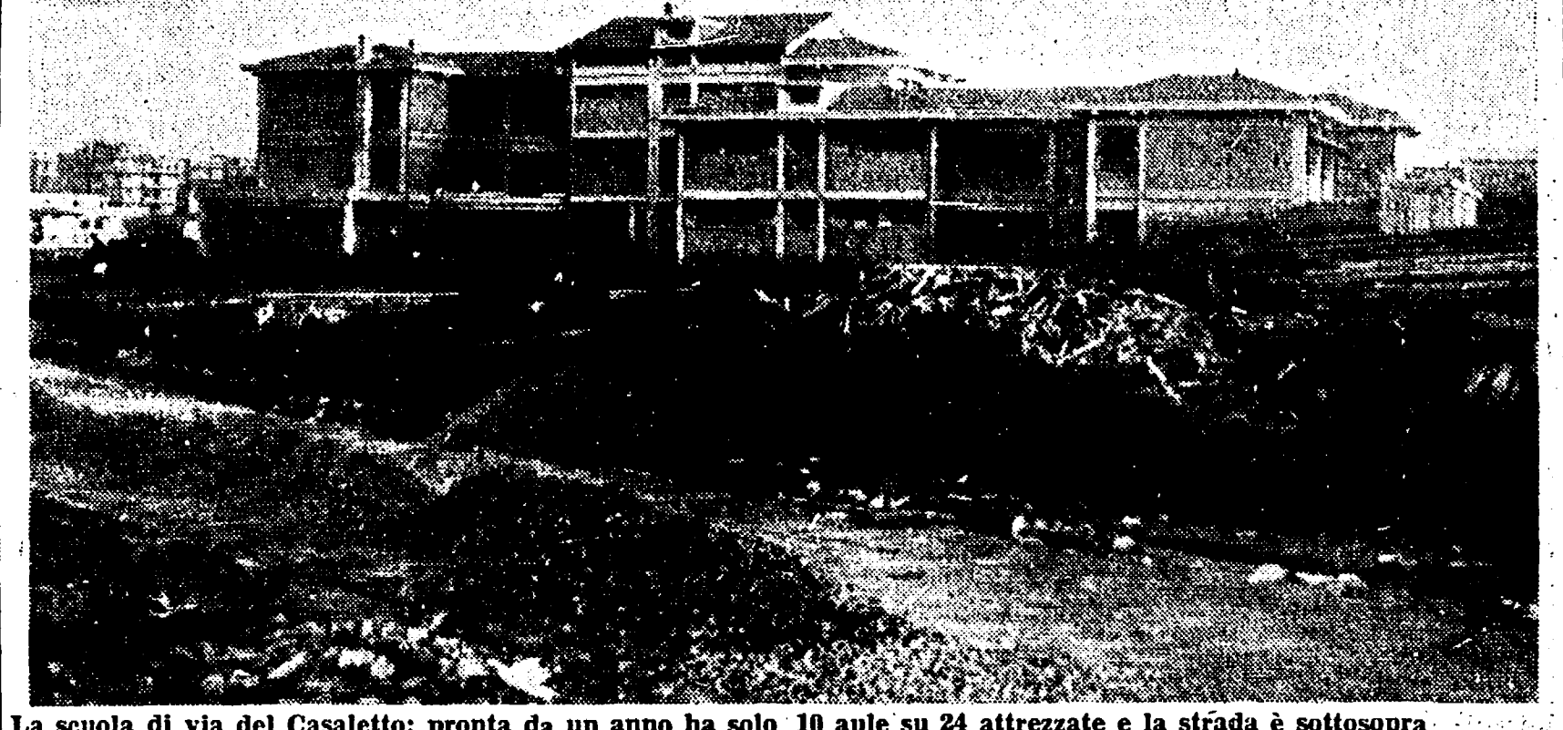
La scuola di via del Casaleto: pronta da un anno ha solo 10 aule su 24 attrezzate e la strada è sottoposta
