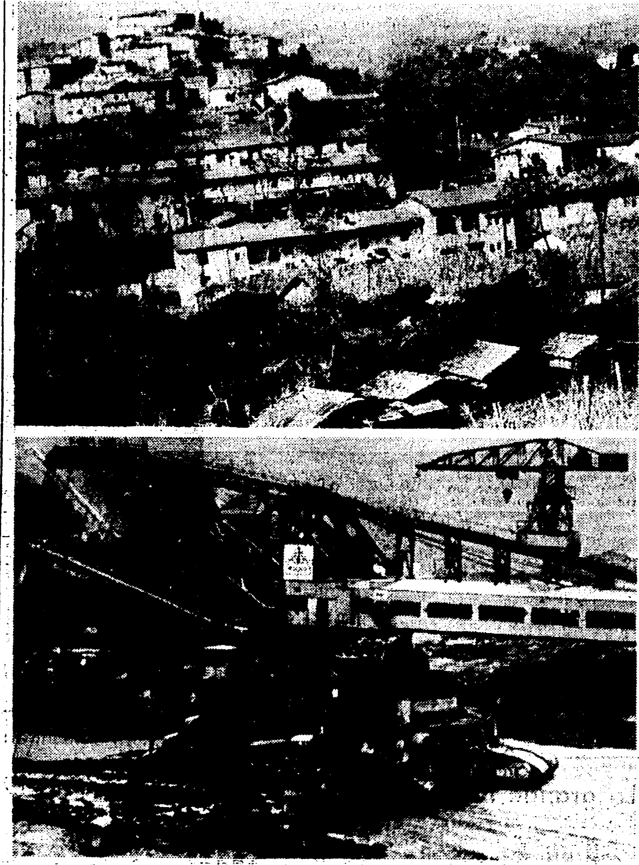
CASTELNUOVO DEI SABBIONI - Sopra: panorama del paese. In primo piano la borgata «Dispensa», in parte abbattuta. Sotto: escavatori impiegati nel banco lignitifero. Sullo sfondo, a sinistra, un nastro trasportatore.
