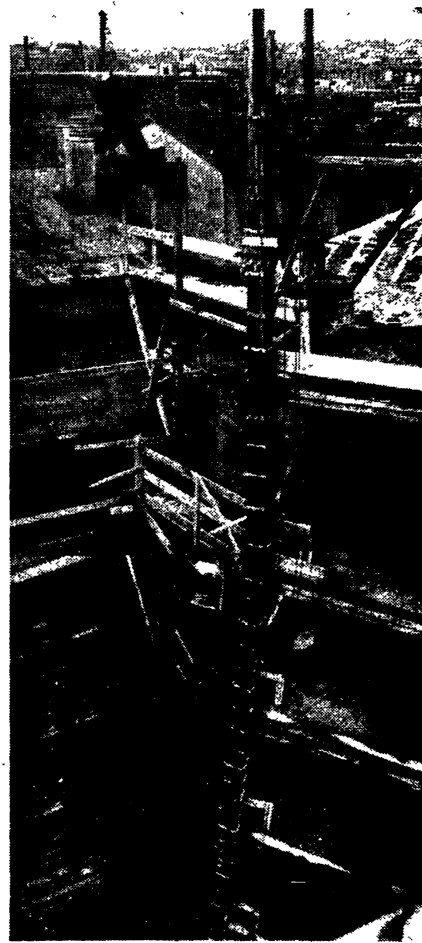
Una visione dell'agghiacciante sciagura. La freccia indica il «ponte» che ha ceduto.
