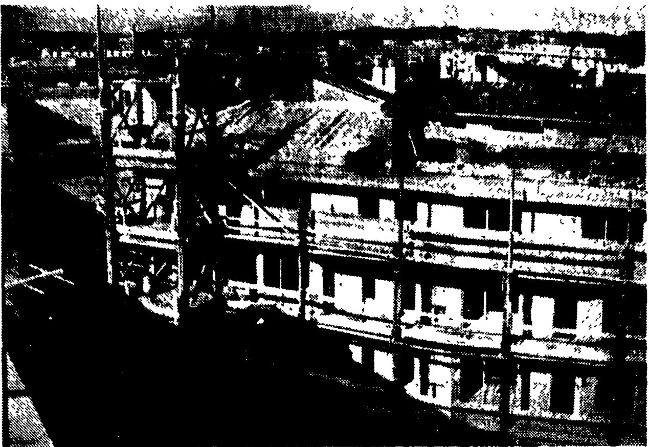
Nessuna protezione lungo tutto il perimetro del tetto dove gli operai lavorano a oltre 25 metri dal piazzale. A destra: il cadavere di uno dei due operai rimasti travolti nel crollo.
