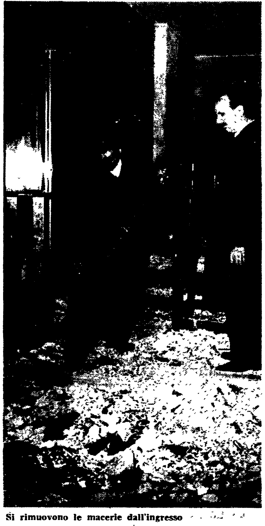
Si rimuovono le macerie dall'ingresso
