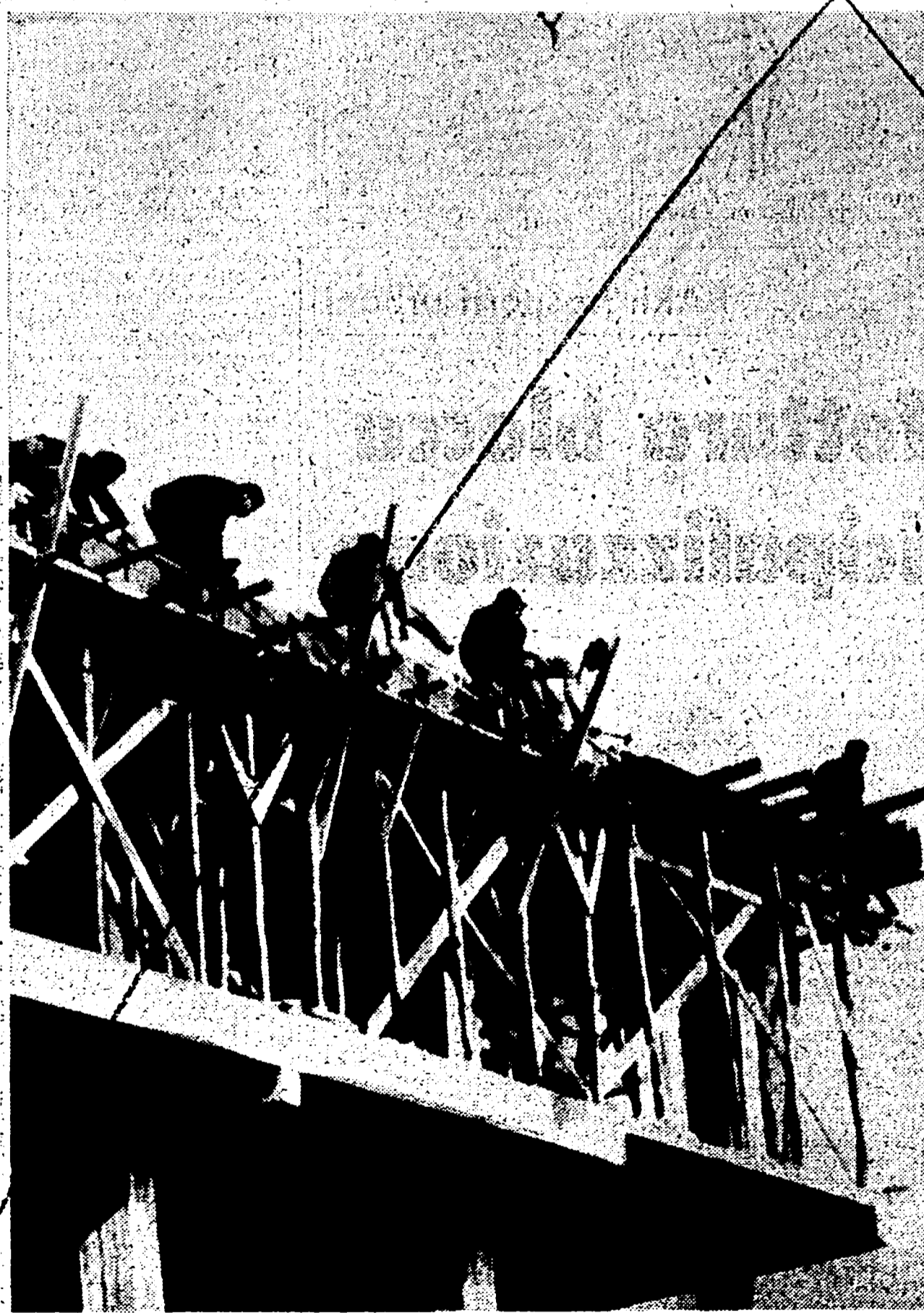
Ecco in quali condizioni lavorano gli edili: senza alcuna misura di protezione a tutela della loro incolumità. I rischi sono tutti per i lavoratori; i profitti tutti per i padroni. Di questo i giudici che hanno emesso la sentenza di Roma non hanno voluto tener conto!
