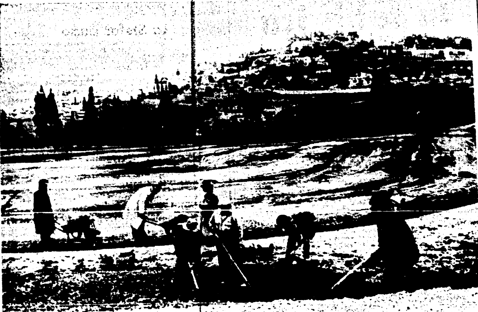
GERUSALEMME — Operai al lavoro sulla strada per il monte Sion, che sarà percorsa da Paolo VI.
