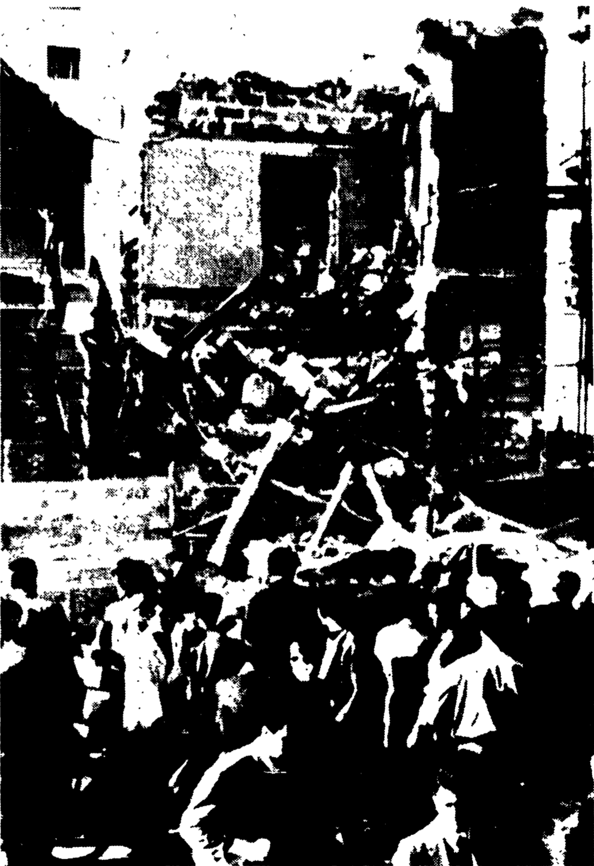
Palermo. Una impressionante visione di quello che resta dell'edificio crollato ieri a Palermo.
