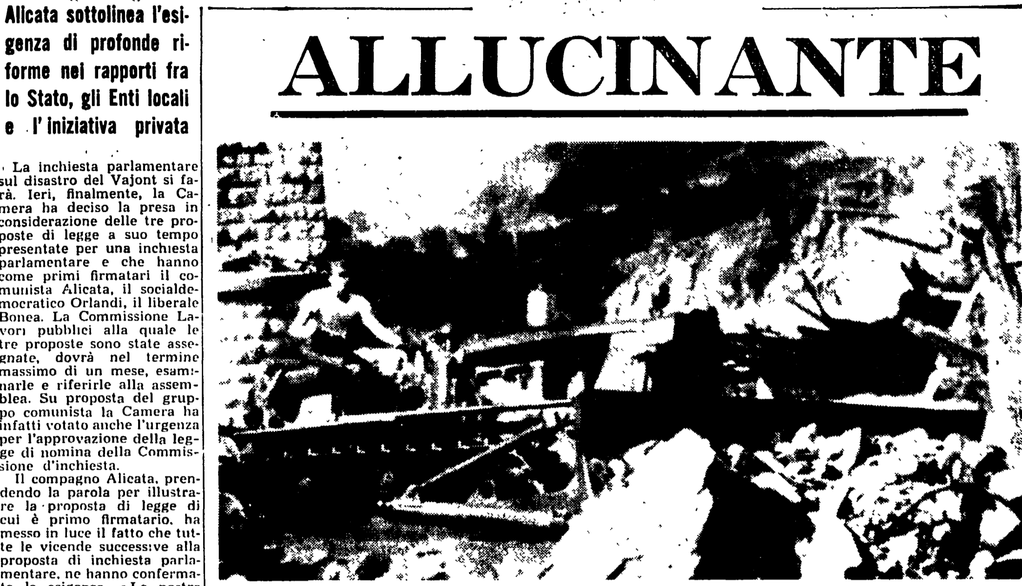
La colossale frana precipitata nel Vajont l'ottobre scorso era già impostata come superficie di particolare significato meccanico nella estate del 1960; la struttura geologica e geologica del bacino avrebbe dovuto scongiurare la costruzione del serbatoio idroelettrico; molti elementi fanno ritenere che, in sostanza, il 9 ottobre del 1963 « si sia rimessa in movimento la grande frana preistorica riconosciuta da numerosi studiosi, tra i quali Giudici e Semenza, la tragedia del Vajont è stata la più clamorosa e drammatica conseguenza.
