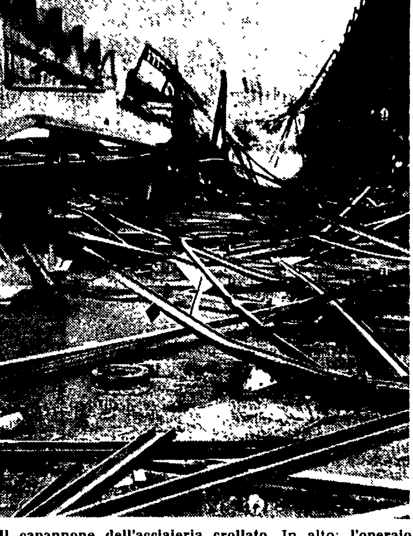
Il capannone dell'acciaieria crollato. In alto: l'operato Gennaro Letteri morto in seguito al crollo.
