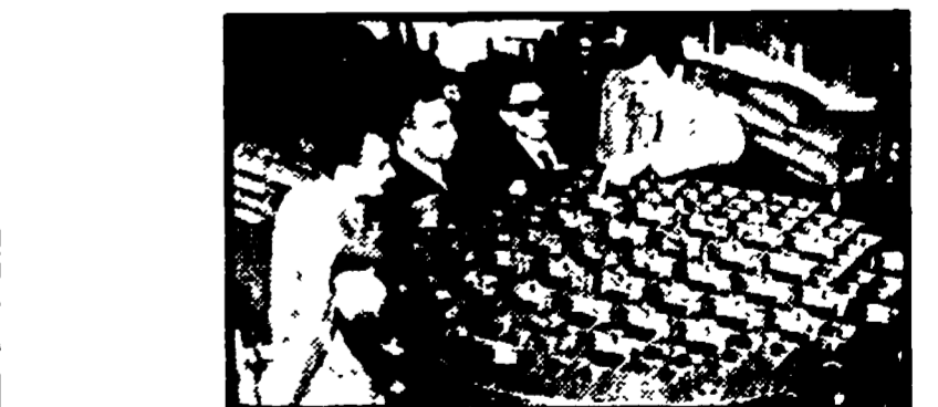
Il supporto del «core» del reattore «Rospo» della Casaccia
