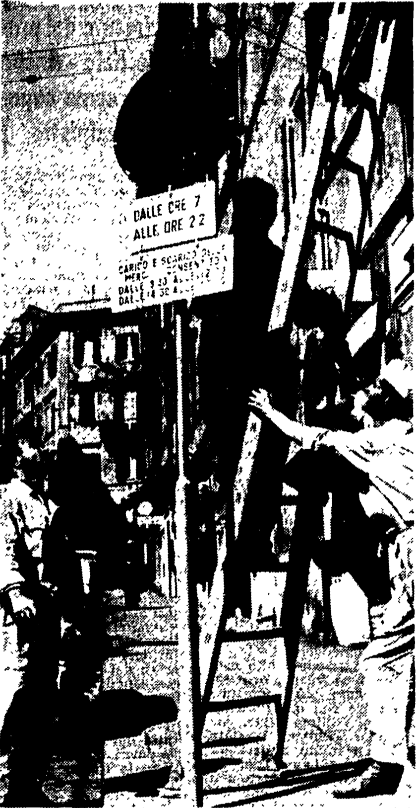
I cartelli della nuova segnaletica stradale sono a posto. L'operazione zona disco è praticamente iniziata. Gli operai (nella foto) stanno sostituendo il vecchio cartello con il nuovo, che impone il divieto per le operazioni di carico e scarico e il divieto di sosta dalle sette del mattino alle 22.
