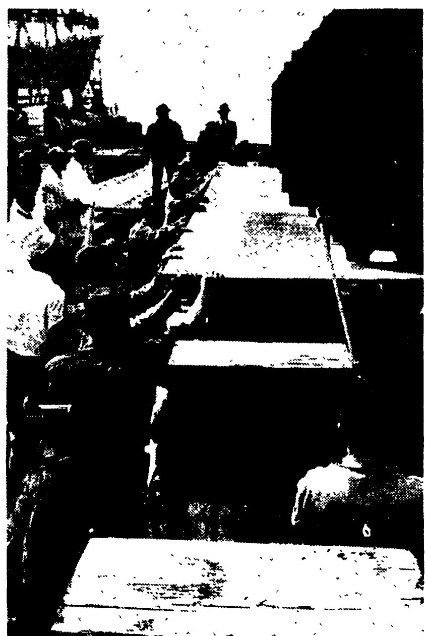
Operai del cantiere Ansaldo di Muggiano durante i lavori per l'impostazione di una nave
