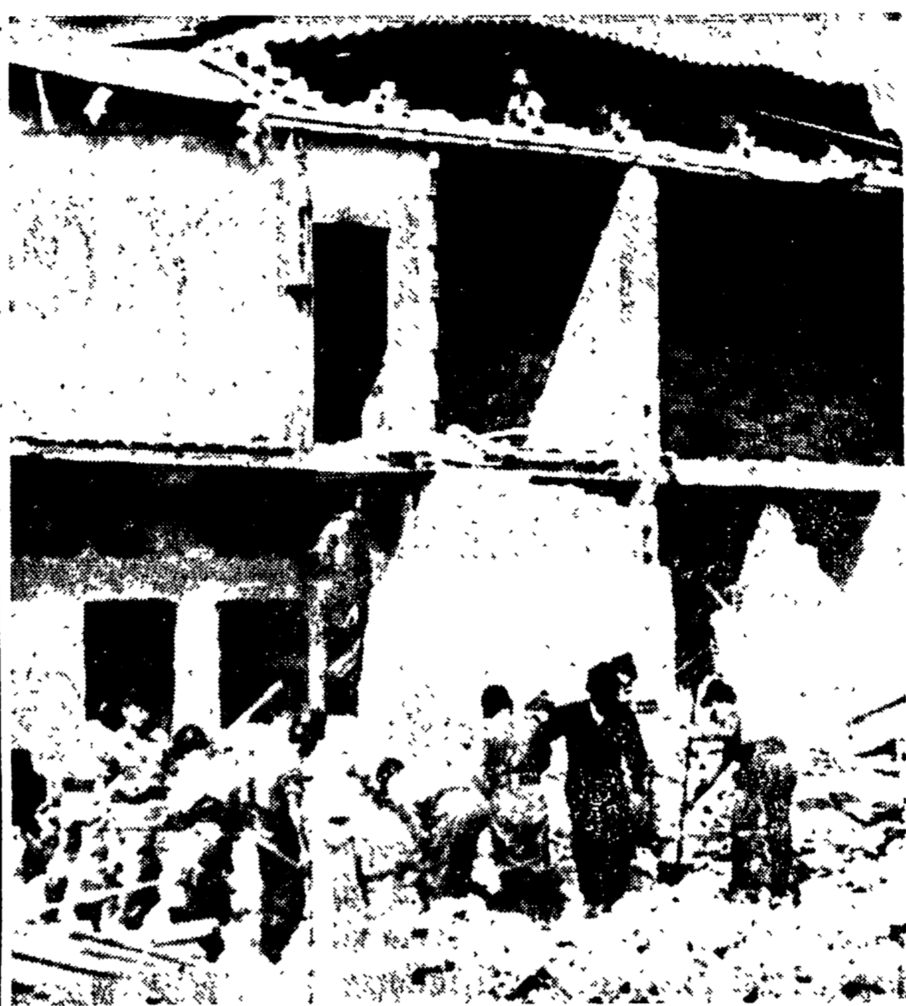
CARAVAGGIO (Bergamo) - Le squadre di soccorso dei vigili del fuoco al lavoro tra le macerie della casa crollata.
