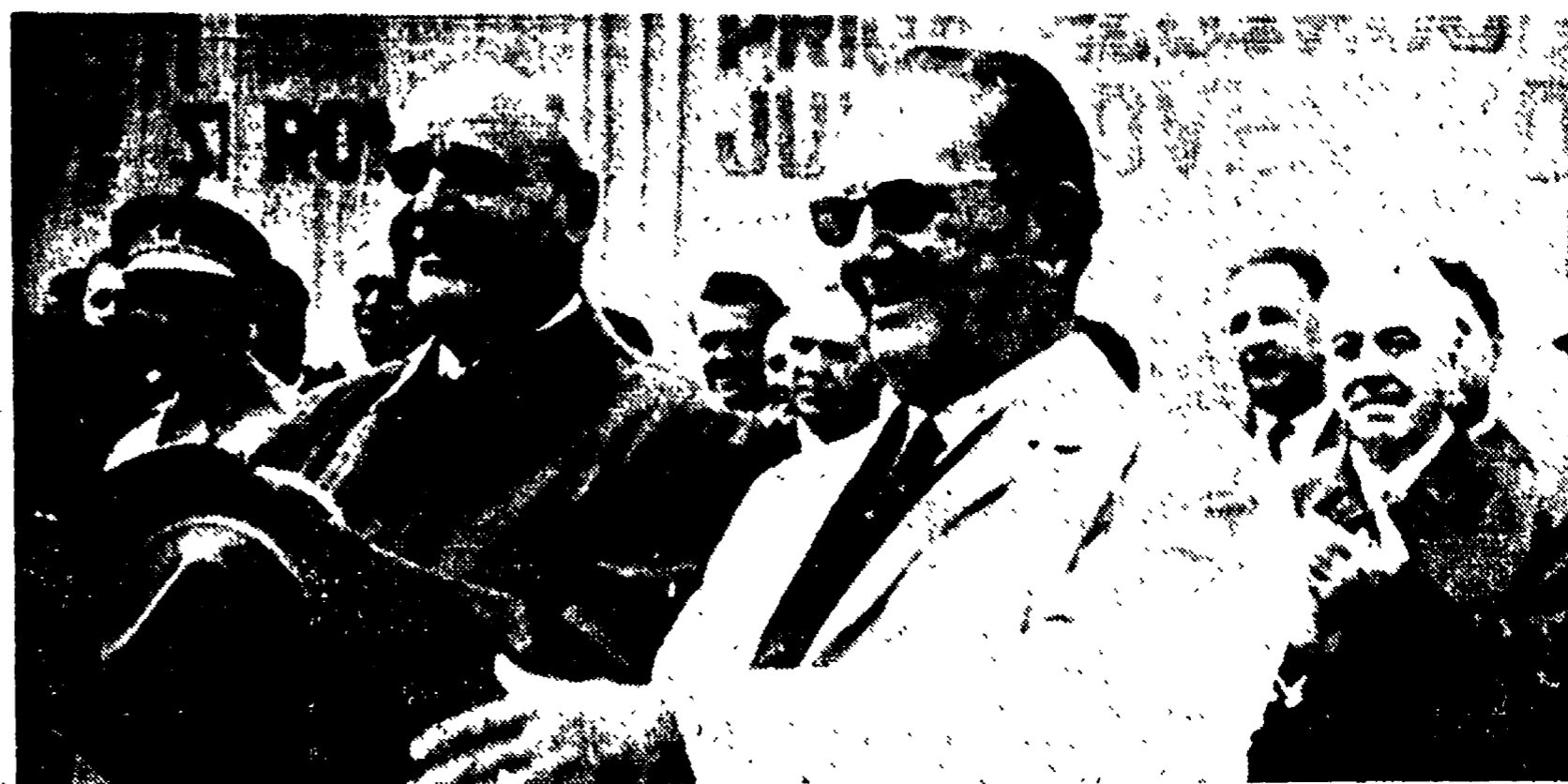
SIP — Tito e Gheorghiu-Dej (a sinistra) presenziano all'inizio dei lavori del più grande complesso idroelettrico d'Europa.
