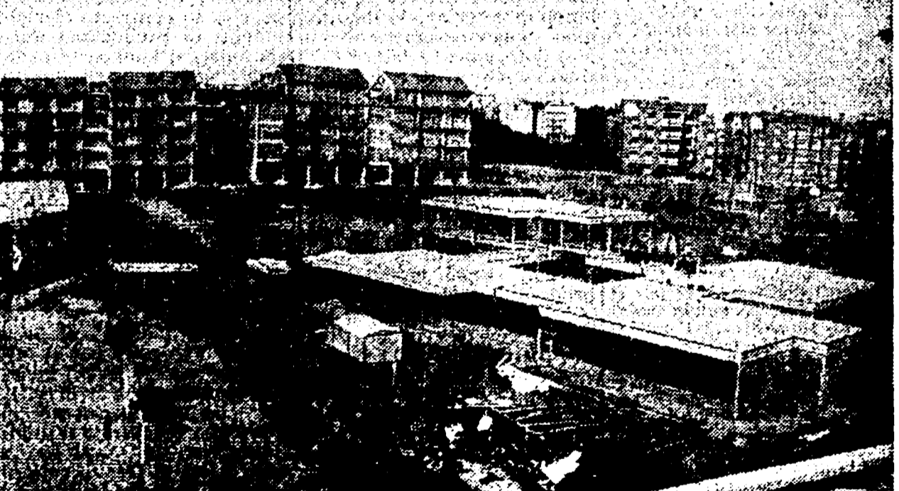
Si nota, a sinistra della scuola «Calasanzio», il gruppo delle aule prefabbricate i cui lavori avrebbero dovuto terminare entro ottobre
