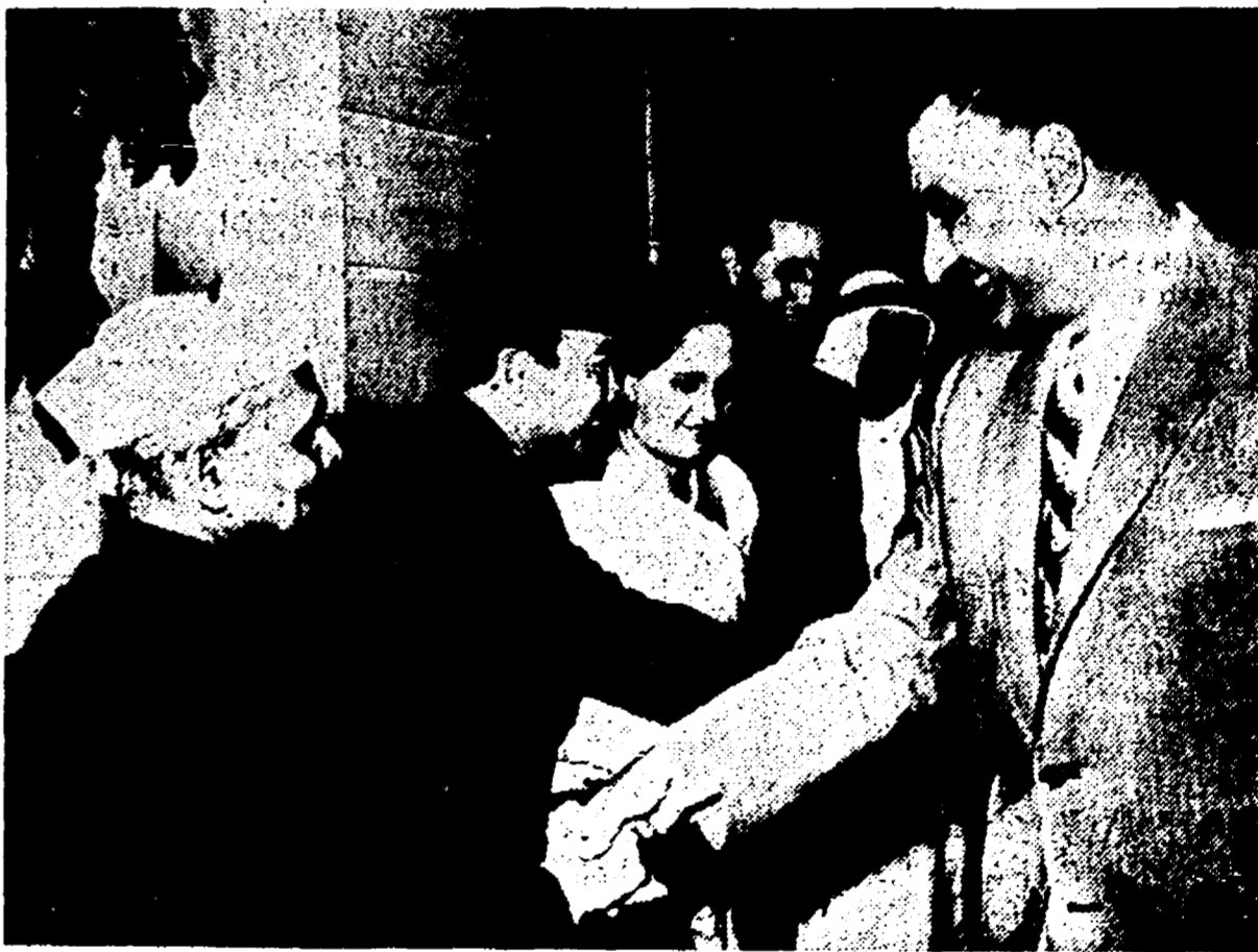
IL CAIRO - Caloroso saluto tra Nasser (a destra) e Shastri prima della seduta conclusiva dei lavori (Telefoto)
