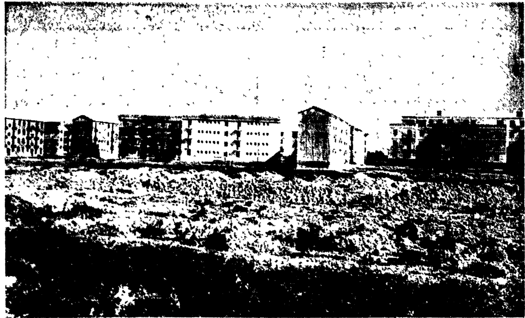
CROTONE: Un nuovo rione sorto nei pressi della stazione
