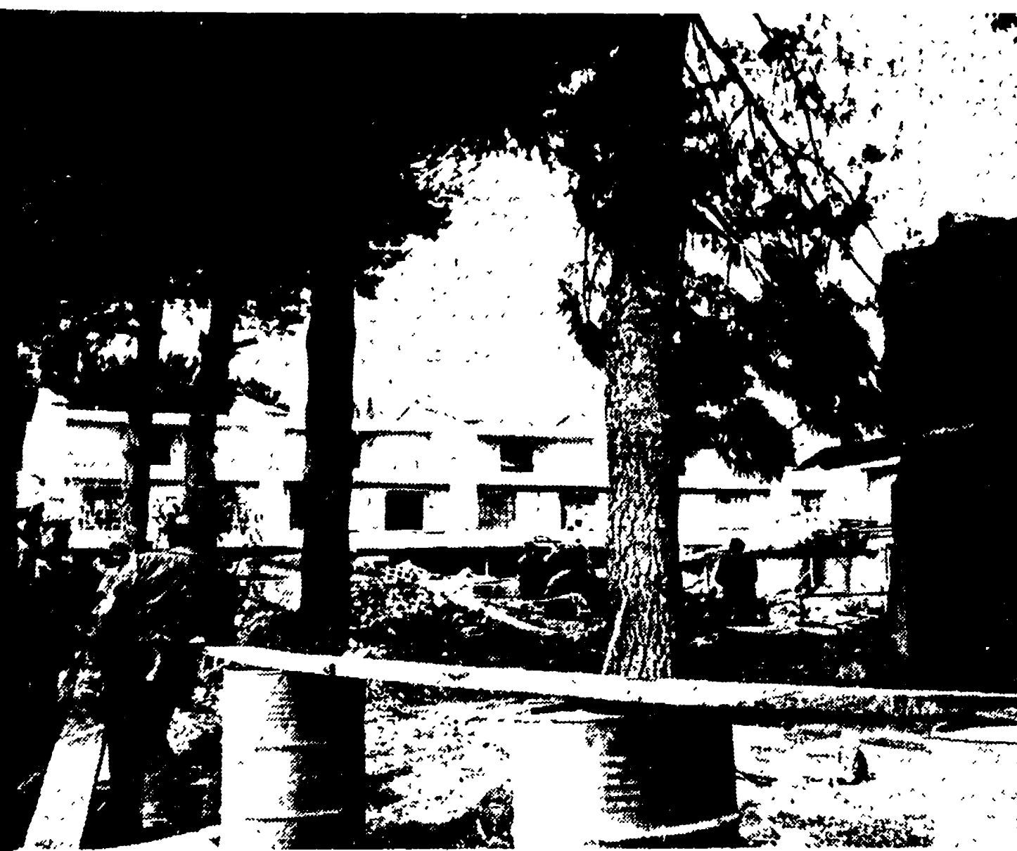
Alcuni operai osservano il luogo della sciagura: sulla destra una parte del capannone crollato.
