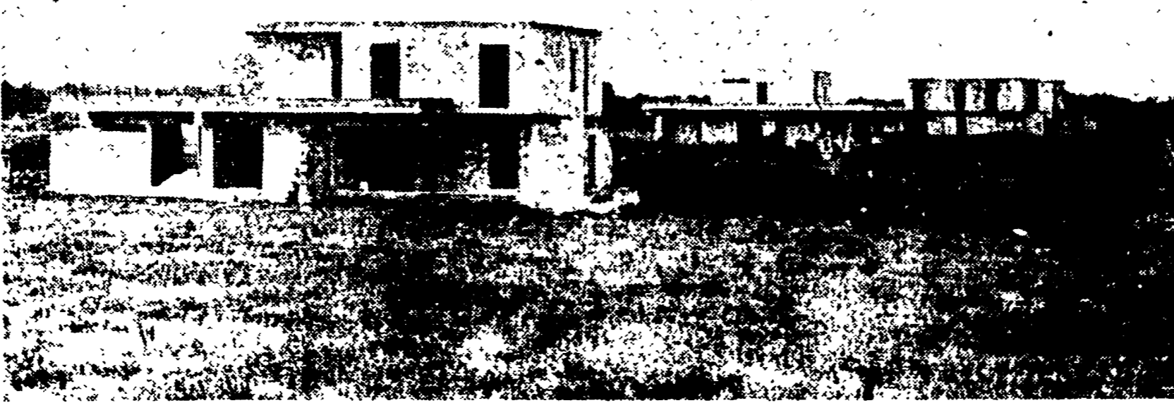
Una veduta del villaggio Adria costruito abusivamente in zona agricola. Sospesi i lavori ora il Consiglio Superiore dei LL.PP. vuol sanare la violazione con un ricatto al Consiglio comunale
