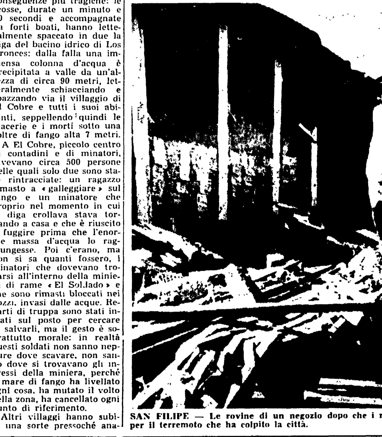
SAN FILIPE — Le rovine di un negozio dopo che i muri dello stesso sono crollati per il terremoto che ha colpito la città.
