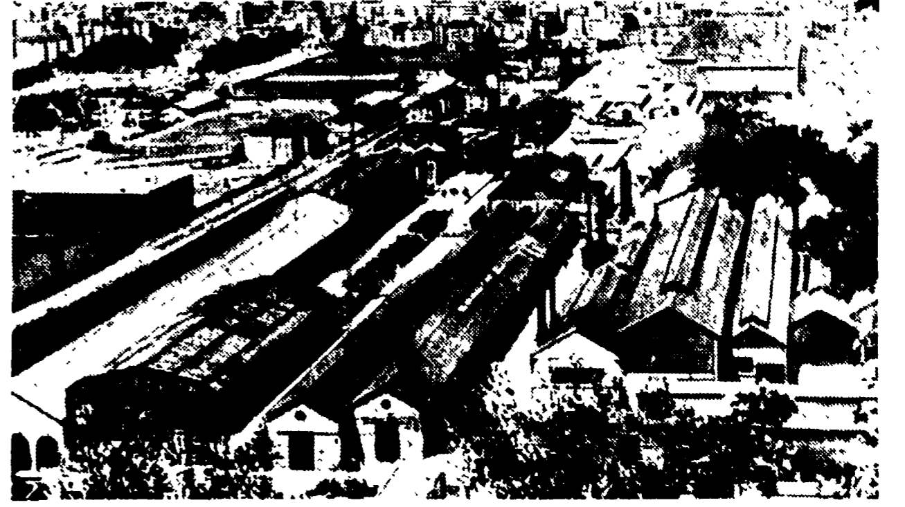
TERNI — Una panoramica dell'Acciaieria
