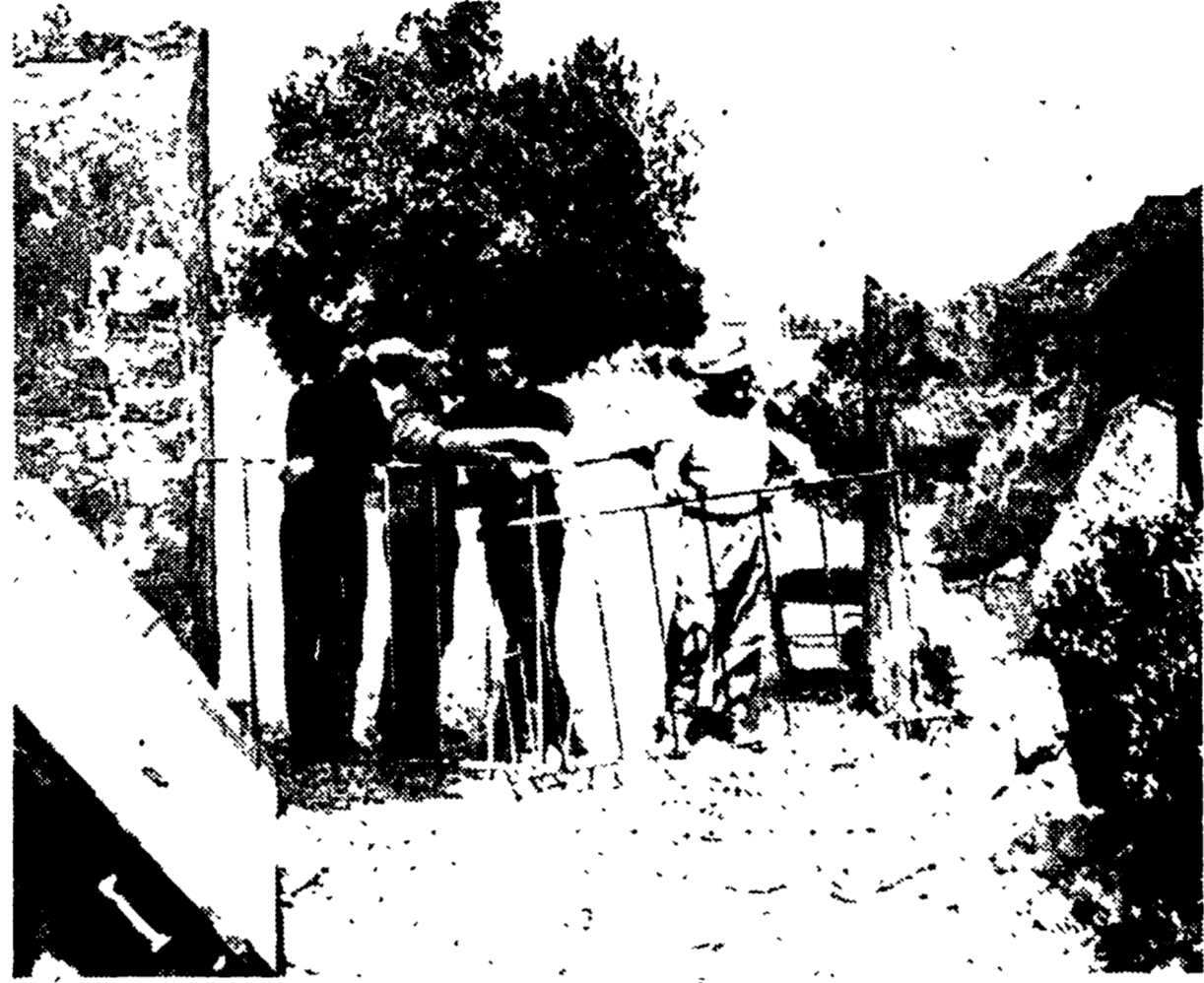
È stato dato il via ai lavori di riparazione del cancello della morte nel convento di Albano: e i primi operai sono già all'opera per sgombrare il terreno dalle macerie...
