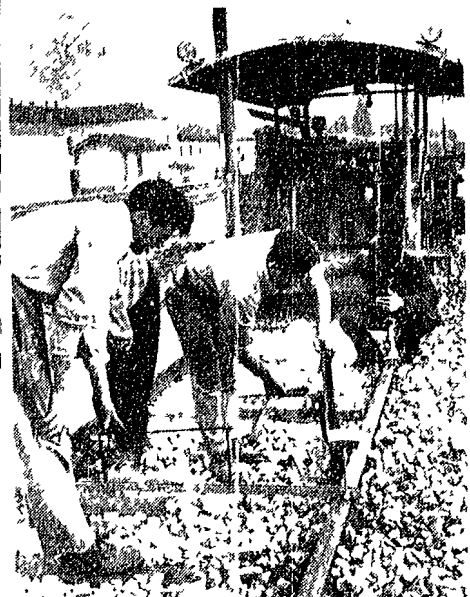
Fra gli appalti vi sono anche quelli del rifacimento di interi tronconi di linea ferroviaria. E' questo un lavoro di esercizio che non potrebbe essere dato in appalto. Nella foto, alcuni operai degli appalti, e il lavoro presso la stazione di Codogno
