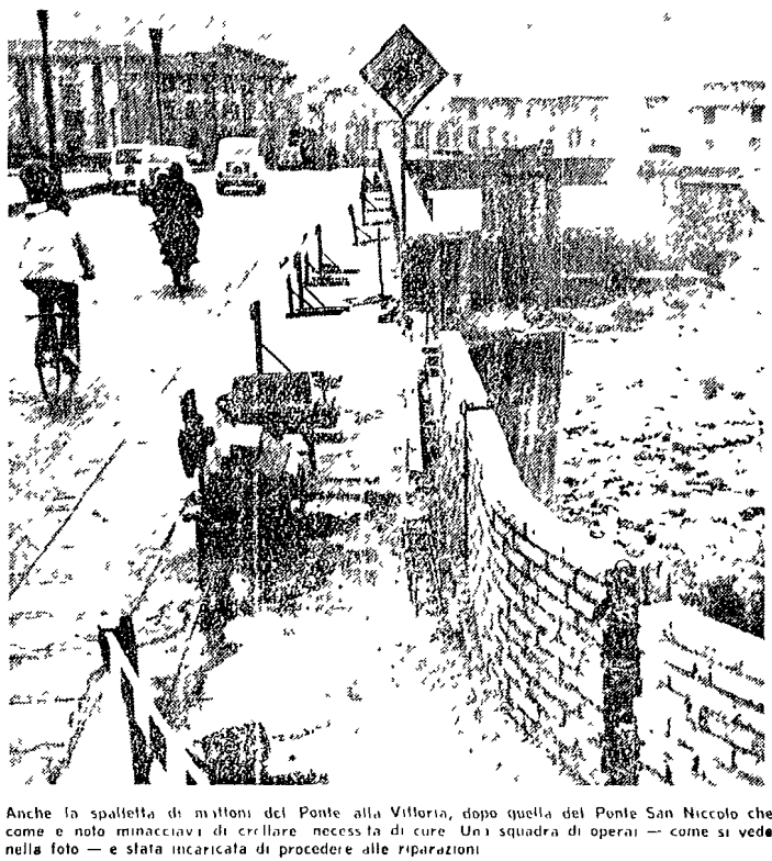
Anche la spalletta di mattoni del Ponte alla Vittoria, dopo quella del Ponte San Niccolò che come è noto minacciava di crollare, necessita di cure. Una squadra di operai — come si vede nella foto — è stata incaricata di procedere alle riparazioni.
