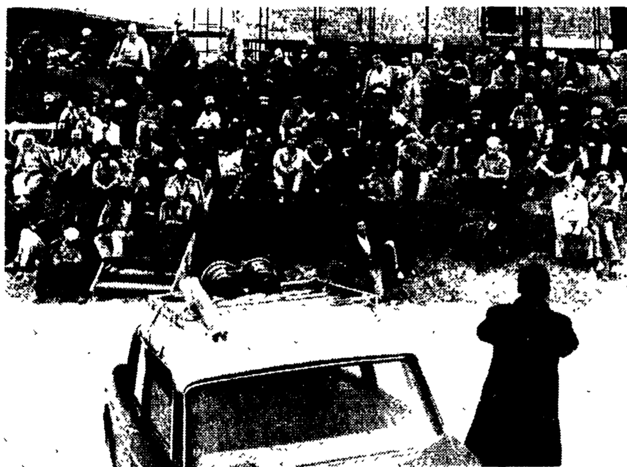
Manifestazioni di edili in un cantiere di Valmalena
