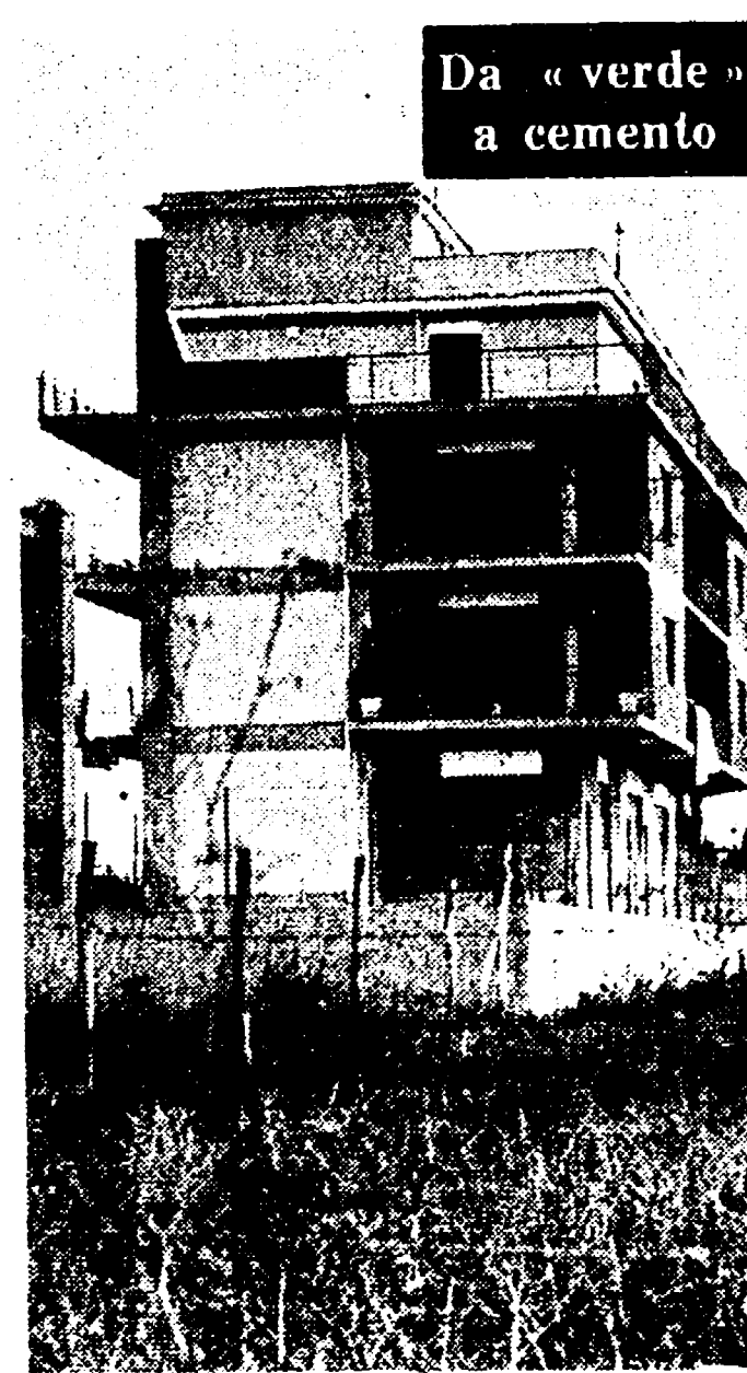
Via di Dragone, ai margini di Acilia: ecco una lottizzazione in corso su terreni di proprietà Corselli. La zona è destinata dal piano regolatore a verde. Vi sono sorte prima alcune casupole e poi palazzine con cubature del tutto libere e fino a cinque piani.
