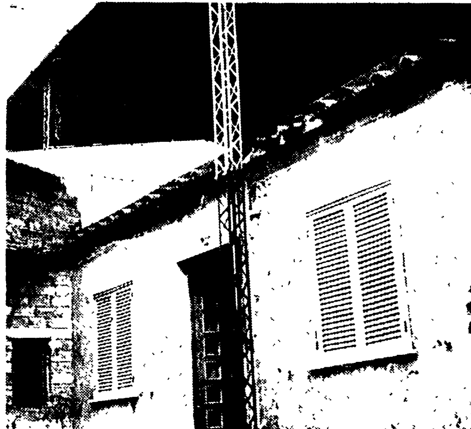
L'ingresso della scuola elementare di Tor Angela. Per impedire che, come è successo molte volte, nelle aule piovesse, il proprietario ha addirittura costruito un altro tetto.
