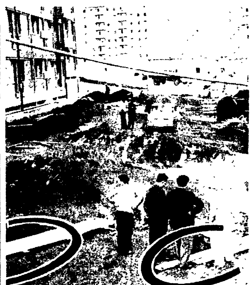
Quattro tombe antiche sono venute alla luce durante i lavori che si stanno svolgendo in un cantiere edile di Torre Spaccata, alla borgata Alessandrina. Alcuni operai, con particolare attenzione, scoprirono un gruppo di case del IV-V secolo, mentre scavavano al suolo un acciottolo che serviva da base per la costruzione di una casa. In un altro punto del cantiere sono apparse quattro tombe, delle quali tre erano vuote e una conteneva i resti di uno scheletro. Del ritrovamento sono stati informati il commissario di zona e i tecnici incaricati della Soprintendenza alle Antichità. Questi ultimi, a sua volta, ha dato l'ordine di sospendere i lavori di sterco stano eseguiti con particolare attenzione. Dal primo e superficiale accertamento pare si tratti di tombe dell'epoca romana: alcuni indizi fanno anche credere che quella zona nasconde una vera e propria necropoli e non solo quelle quattro tombe.
