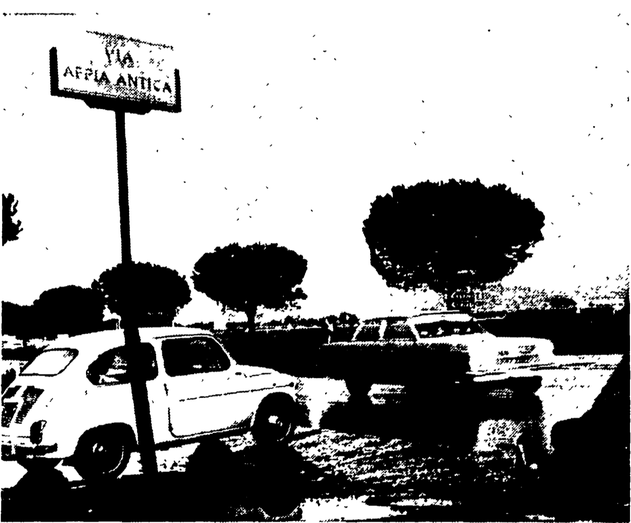
RACCORDO ANULARE, chilometro 48+400. Questo incrocio con l'Appia Antica è un vero trabocchetto. Qui, senza possibilità d'equivoci, la strada è responsabile di ogni incidente. Chi deve attraversare il Raccordo (e numerose vetture sono di turisti, di stranieri) ha la visuale impedita dalla siepe antiabbagliante al centro della velocissima arteria — in questo tratto a due carreggiate — percorsa tra l'altro da moltissimi autotreni. Sul Raccordo anulare, tra gli svincoli per l'Appia e questo incrocio, in neppure mezzo chilometro, sono avvenuti nel 1965 19 incidenti, due dei quali mortali: e la tendenza, da un punto di vista statistico, è all'aumento.
