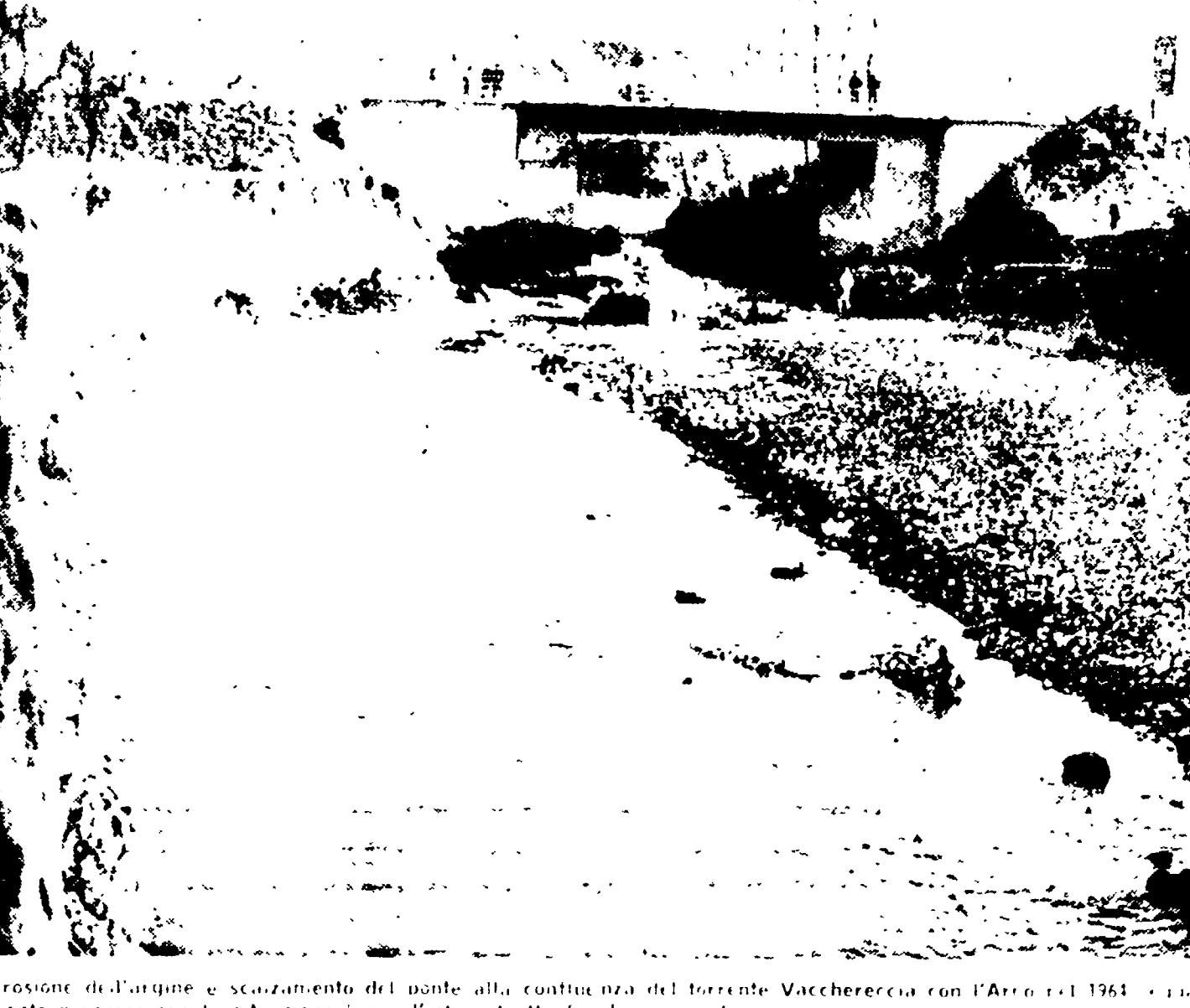
Erosione di argine e scollamento del ponte alla continua del torrente Vaccheresia con l'Arno nel 1961. In primo piano la situazione lungo l'intero tratto fra Leone e Torra.
