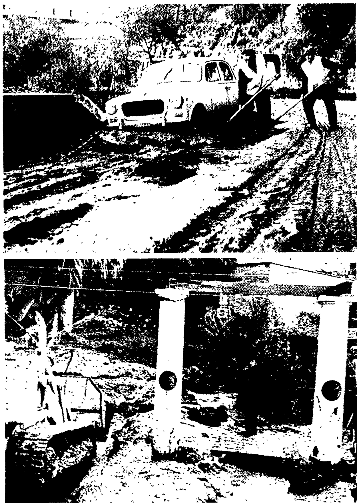
NAPOLI — Uomini e mezzi al lavoro per rimuovere i detriti della frana.
